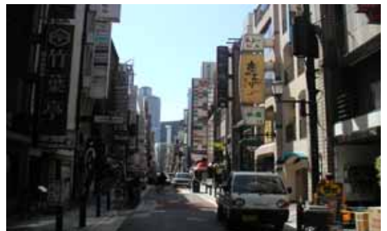
電線の地下化と石畳設置の効果 北新地
